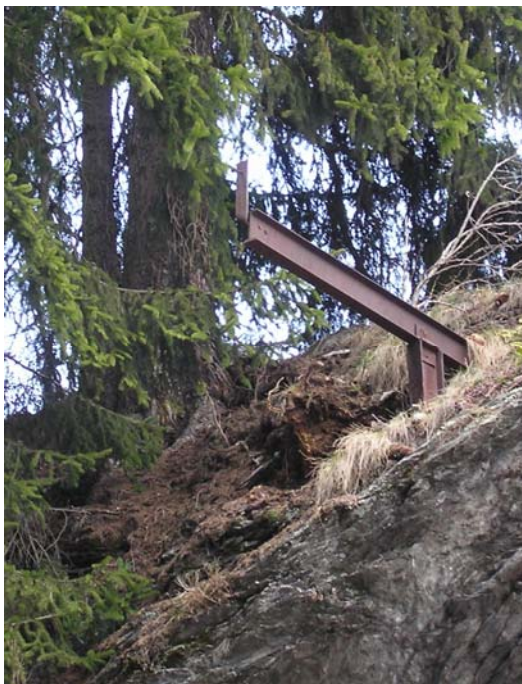
Sulla sponda del Foscagno è rimasta la putrella di sostegno allo scusoir che convogliava l'acqua del Cadangola
