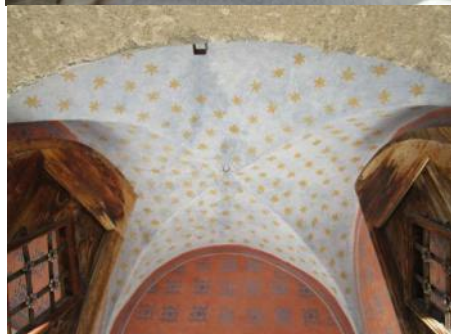
L'interno e il soffitto restaurati
